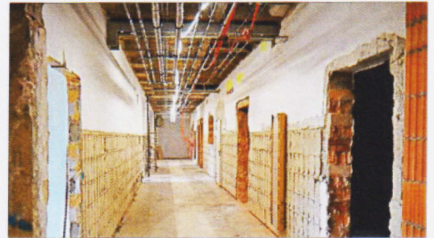
Zug um Zug können jetzt die neuen Versorgungsleitungen verlegt und die Böden, Decken und Wände neu verkleidet werden.
